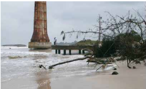
Erosion au Cap Lopez
